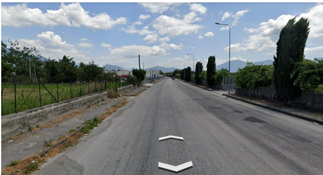
Figura n. 3 – Stato attuale di via Cimitero
