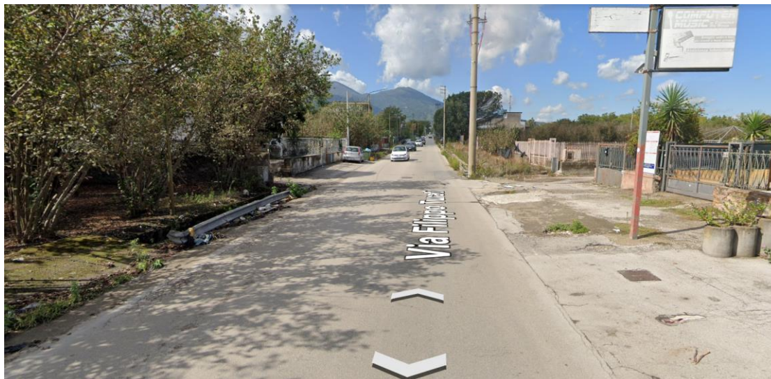
Figura n. 5 – Stato attuale dell’ultimo tratto di Via F. Turati
