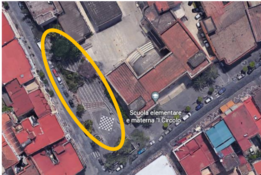
Area oggetto di intervento
